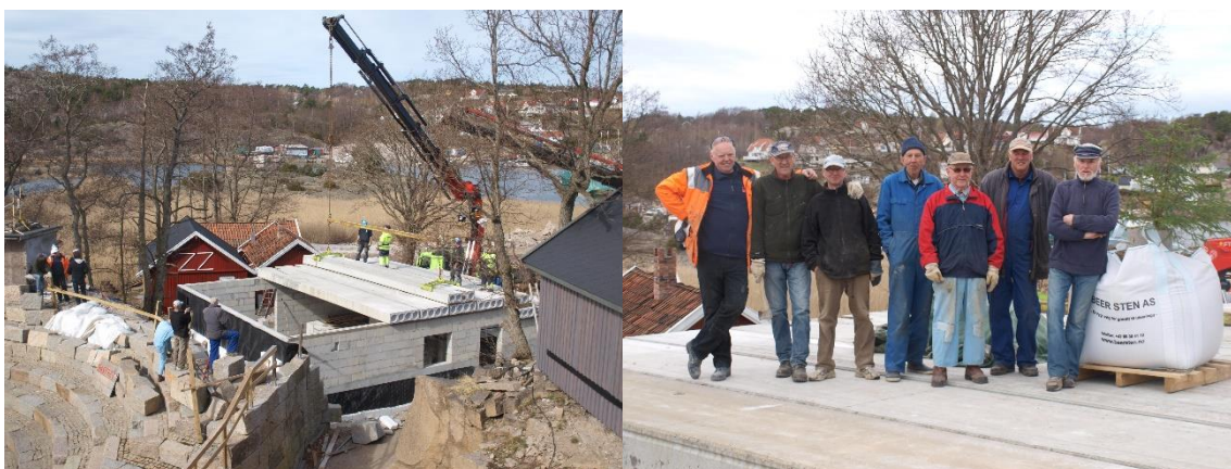
Bildene tatt våren 2012 da Kynningsrunds kranbiler kom med takelementene på hovedbygget. Takelementene på toalettbygget kom i mars 2013. En fornøyd dugnadsgjeng overvar det «store løftet»: Fra høyre Jan Arntzen, Tom Buskoven, Leif Hansen, Kennet Baarstad, Steinar Pettersen, Jan Appelgren og Willy Mølberg.
