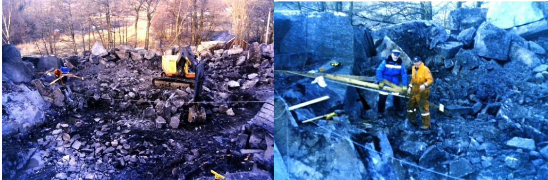
Helge Fredriksen, Jan Arntzen og Reidar Juul Reinertsen (i gravemaskinen)
