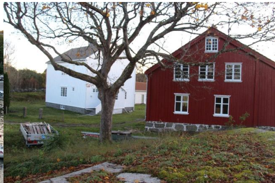
Restaurering av gamle Brekke skole
