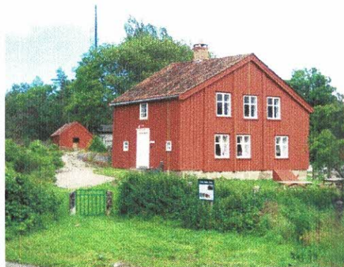
Gamle Brekke skole med tilhørende stolpehus ferdig restaurert 2019
