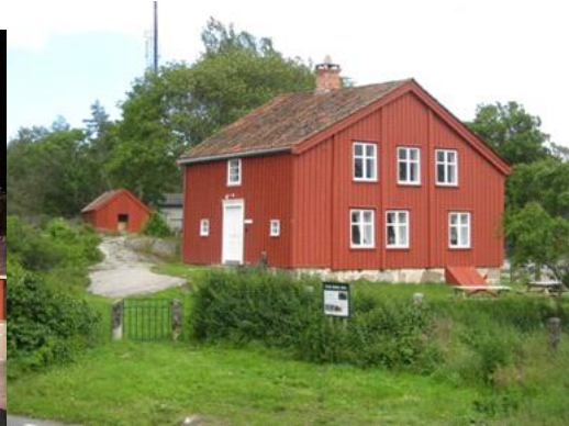
Ferdigstillelse av Brekke skole og stolpehuset
