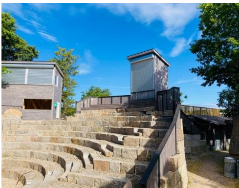
To av til sammen fem tårn ble utbedret i 2020
