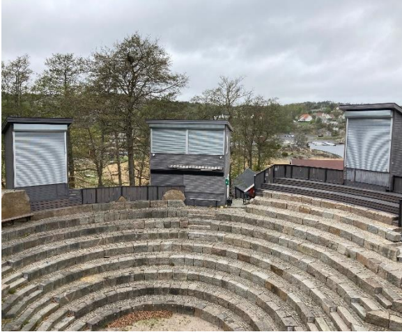
Avsluttet arbeid på fem lystårn i Brottet
