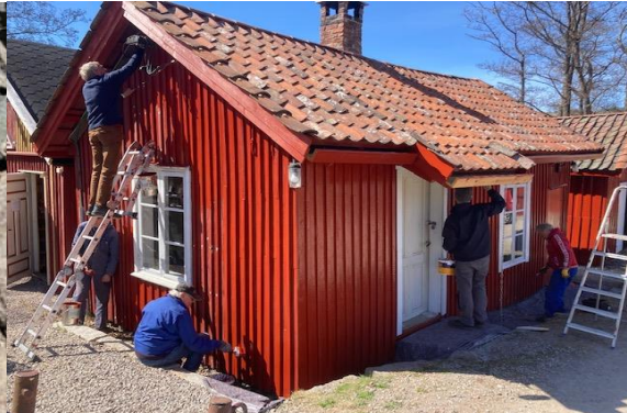
Avsluttet arbeid på smia og maskinhuset
